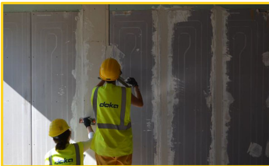
Montarea panourilor radiante în casa EFdeN 4C
