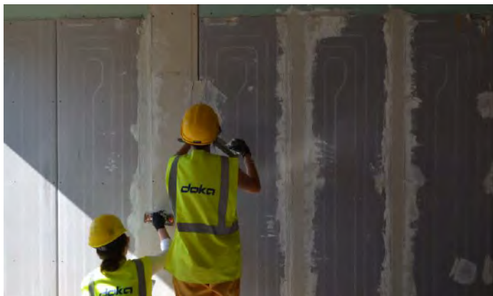
Montarea panourilor radiante
