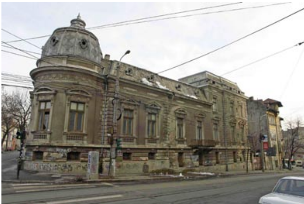
Fosta clădire din str. Știrbei Vodă nr. 89, colț cu str. Berzei
