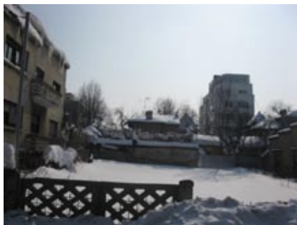
Strada Sandu Aldea nr. 30, după demolare
