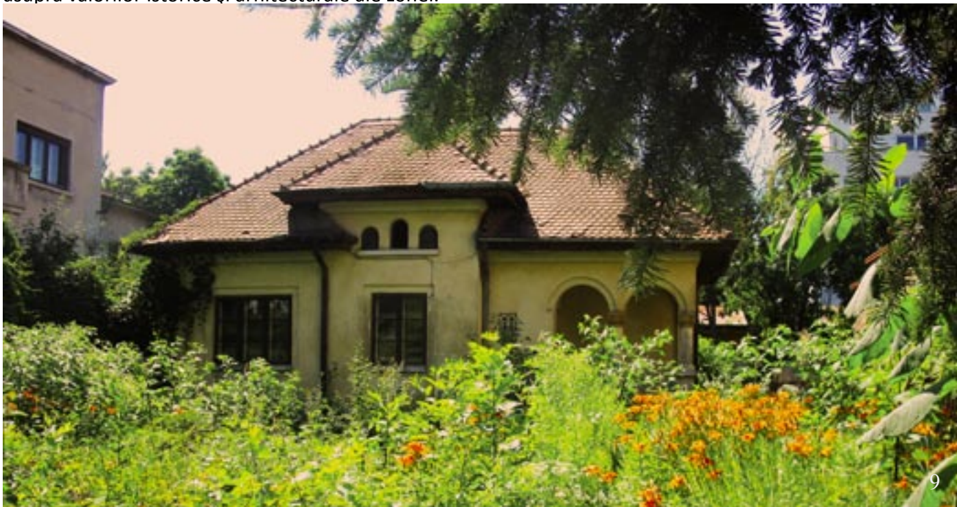
Imobilul din strada Sandu Aldea nr. 30, înainte de demolare
