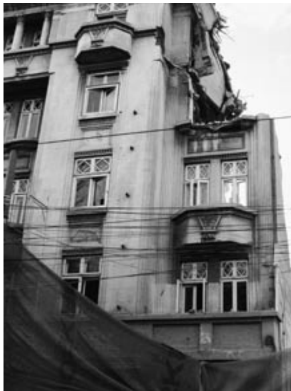
Fostul hotel Marna -în timpul demolării; strada Buzzești nr. 6
