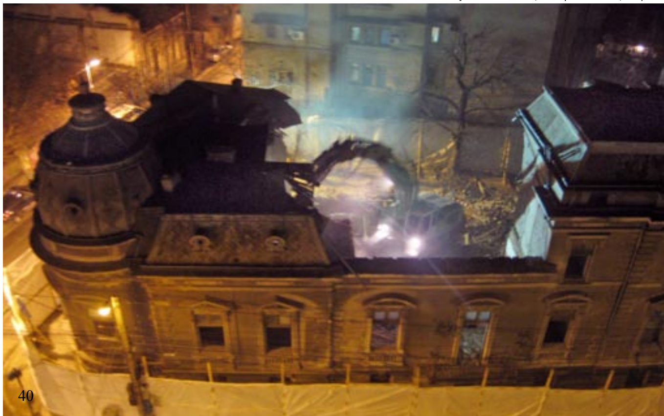
Fosta clădire din str. Știrbei Vodă nr. 89, în timpul demolării, noaptea
