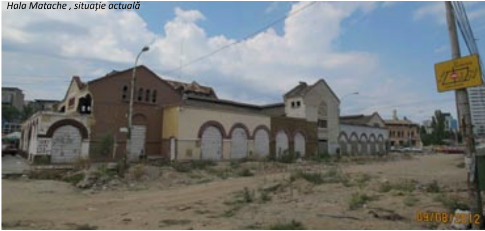
Hala Matache , situație actuală
