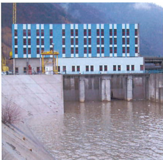
Fig.1. CHE Robesti - vedere aval centrala
