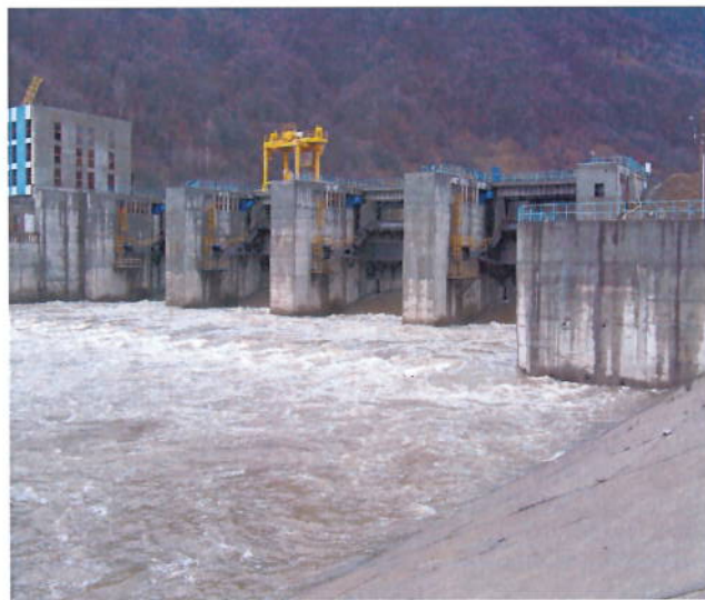
Fig. 2. CHE Robesti - vedere aval baraj
