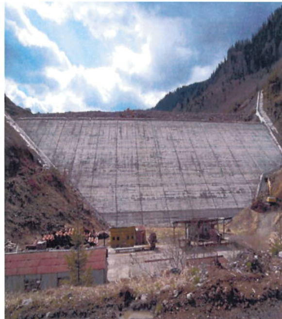
Fig. 4. AHE Rastolita - vedere amonte baraj
