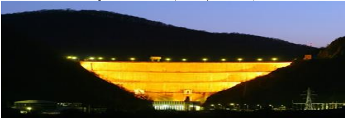
Fig.4.9. Centrala și barajul Tarnița
