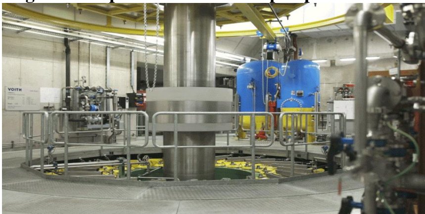
Fig.4.18 Grup reversibil turbina-pompa in functiune
