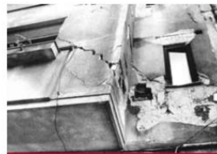
Bowindourile, elemente arhitecturale adoptate în București, care s-au dovedit foarte vulnerabile la cutremurul din 1977 (Calea Moșilor nr. 133)
