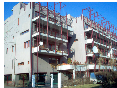
Sistem de fațadă înverzită prevăzută din proiectare la o clădire nouă de locuințe colective din Deva
